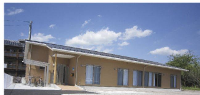
夢ホーム1号館 完成!
