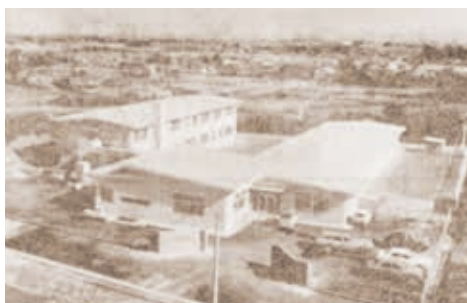
旧糸口第二厚生園竣工時の様子
