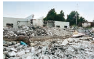
給水塔と旧糸口通勤寮（女子棟）
