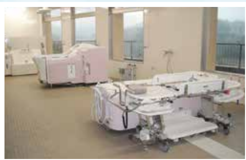
浴室・機械浴槽
